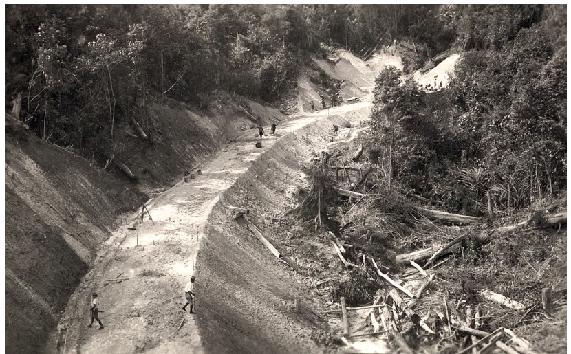
Titel: Aanleg van een weg naar het boorterrein van de Bataafse Petroleum Maatschappij bij Balikpapan. Digitales Bild. Common Copyright. Persistente URL (2015.): http://hdl.handle.net/1887.1/item:739576
